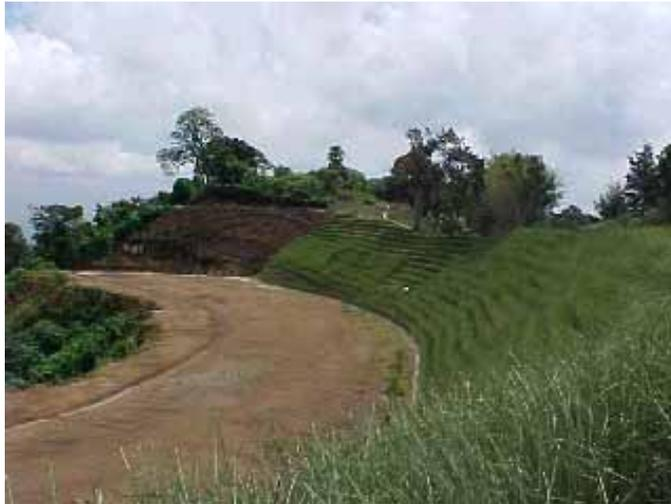
Obras de corrección de la pendiente del talud de la Cordillera del Bálsamo en el sector de las colinas ocurrido el 13 de enero del 2001, a fin de reducir la amenaza por deslizamientos de tierra.
