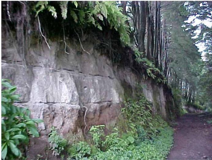
Perfil zona finca Desire o Agua. Parte superior depósitos de ceniza volcánica pomicítica; parte inferior parte inferior estratos de suelo arcilloso rojizo.
